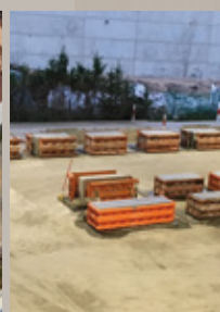
Fabricación de bloques GDP utilizando moldes de encofrado
